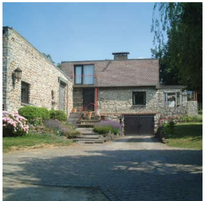
Westgevel atelier en voorgevel van de woonruimten.
